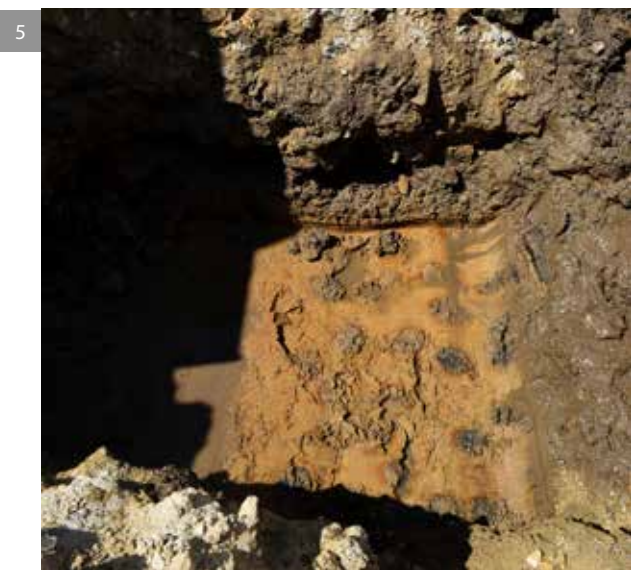
Fig. 5. Raster van funderingspalen in de natte quartaire leem (© ARON bvba).
