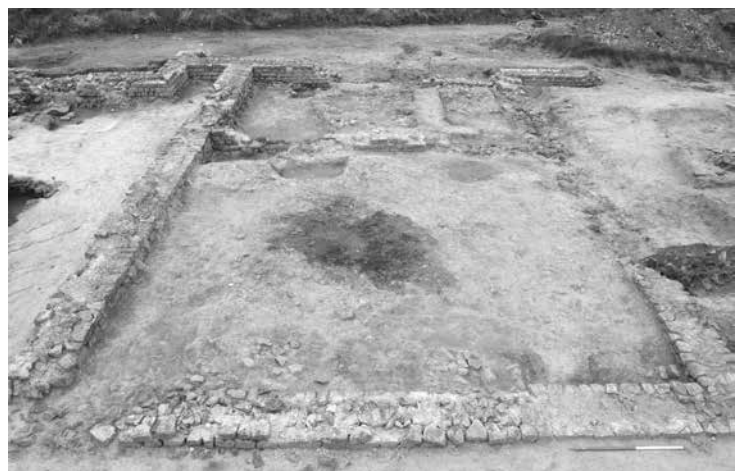
Fig. 1. Photos de localisation de quelques structures brûlées du logis de la villa de « Lizée » (S. Lefert © archeolo-J).
