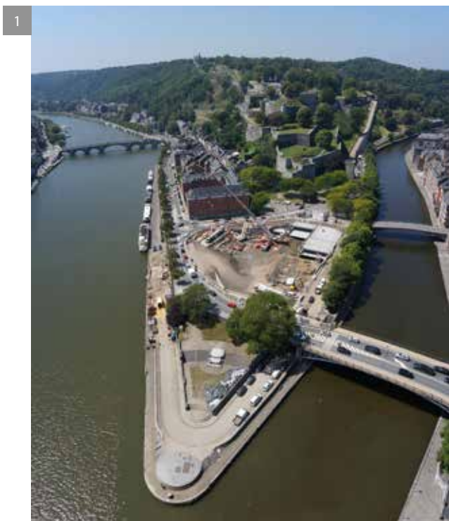
Fig. 1. Le Grognon en travaux : archéologie préventive au confluent Sambre-et-Meuse et construction du parking souterrain, en cohabitation (photo : P.-M. Warnier - © SPW/DGO4-Dir. Géomatique).
